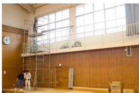
カーテン取替工事
