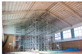
照明 LED 取替工事
