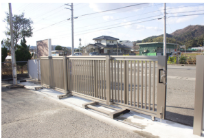
門ゲート扉取り替え
